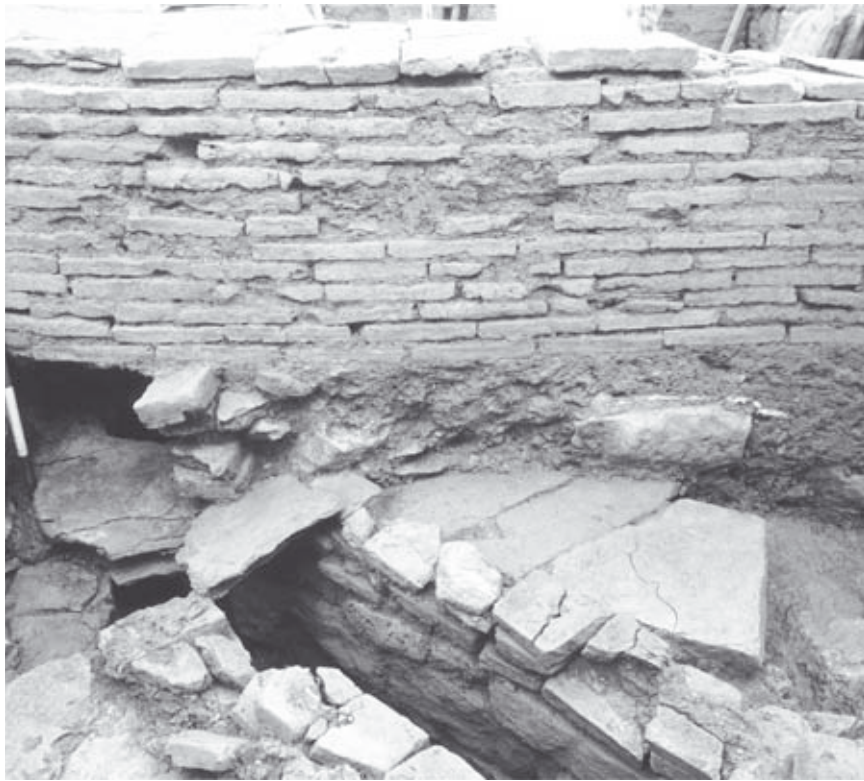
Abb. 43: Raum 34a, Trennmauer zum nördlich angrenzenden Raum 34
