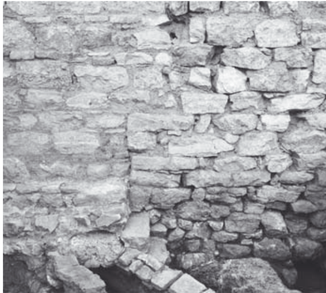
Abb. 47: Raum 34a, Südmauer
