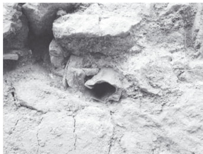
Abb. 25: Raum 34a, Bleirohr in der Ostmauer
