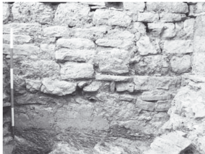
Abb. 24: Raum 34a, Ostmauer
